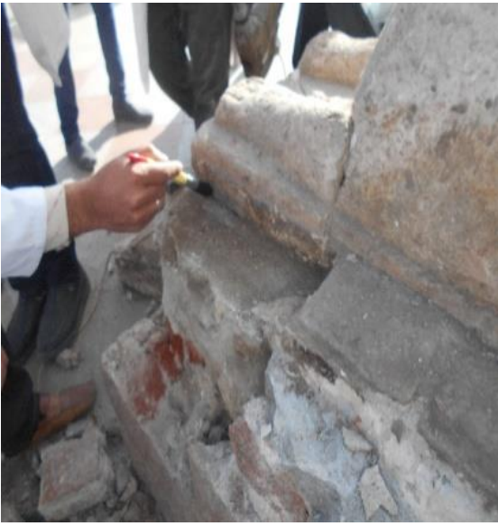
صورة رقم (5) توضح عملية تنظيف قواعد التماثيل الاثرية ب بالفرش بعد إزالة القواعد الخرسانية
