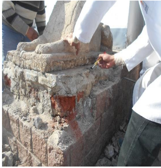
صورة رقم (5) توضح عملية تنظيف قواعد التماثيل الاثرية ب بالفرش بعد إزالة القواعد الخرسانية
