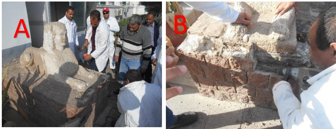
صورة رقم (4) يوضح استكمال إزالة القاعدة الغير اثرية الاظهار وكشف قواعد التماثيل الاثرية حيث ان A استكمال ازالة طبقات القاعدة و B ازالة باقي المداميك
